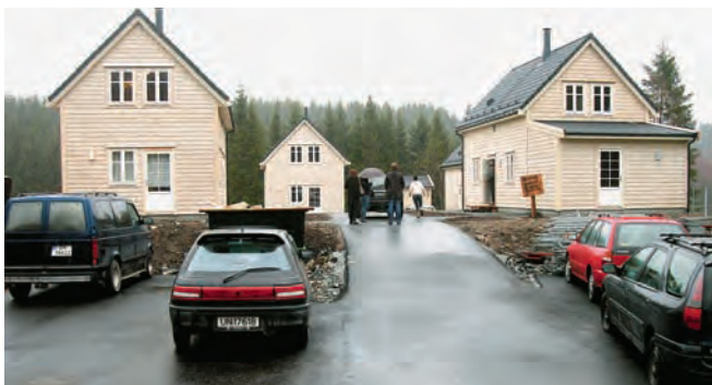
Sjølbyggjarprosjekt i Moltlekleiv.
