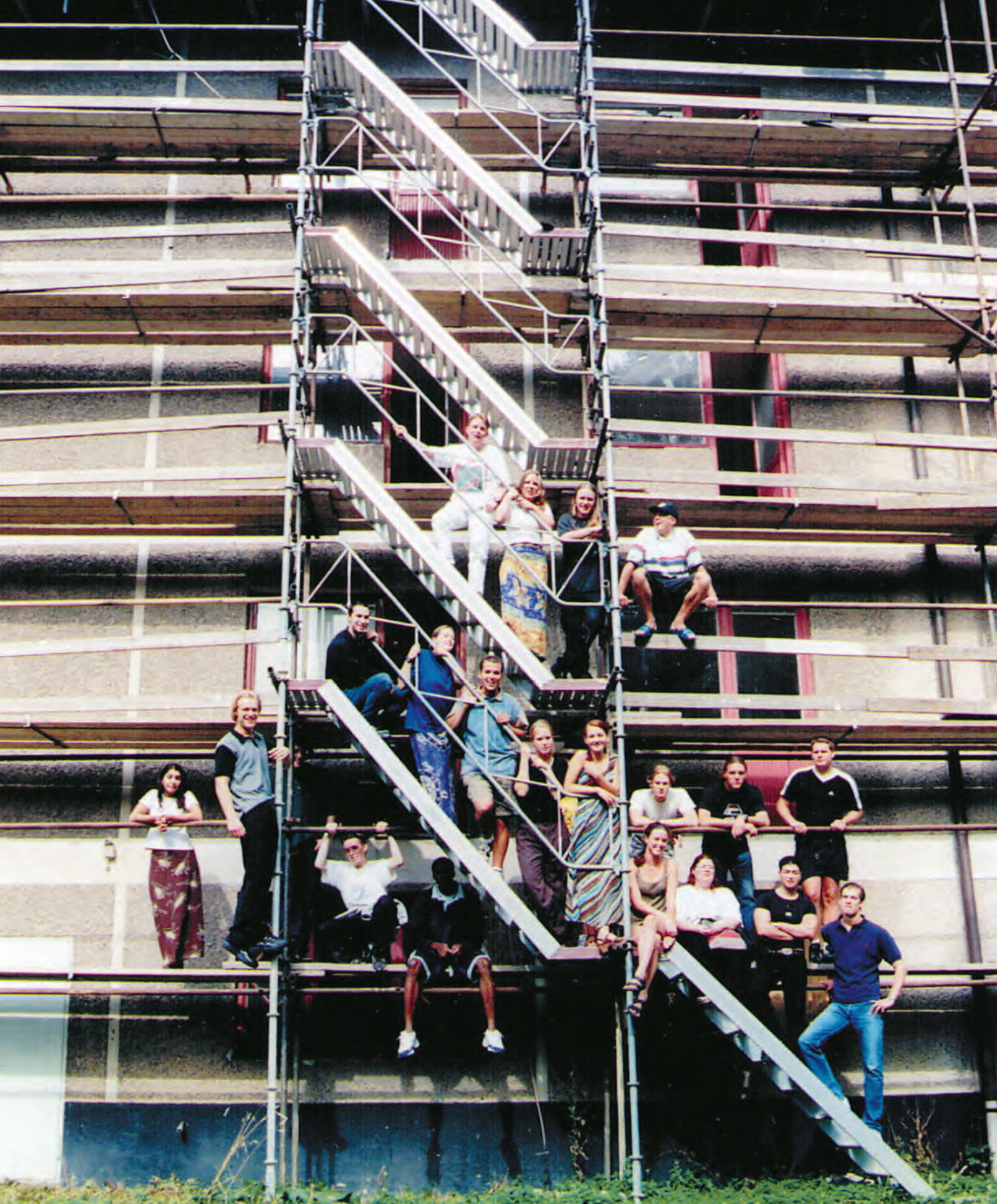
Styremaktene og utbyggjarar meinte at bygningen måtte rivast. Ungdomane i Årsta i Stockholm meinte noko anna og bygde det falleferdige huset om til 57 ungdomsbustader.
